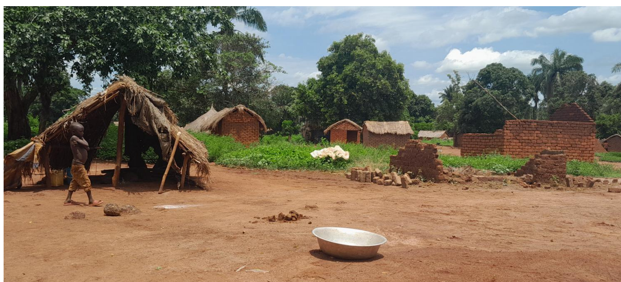
Figure 29: Abris détruits par les incendies sur le site de Ngouli à Obo dans le Haut-Mbomou
